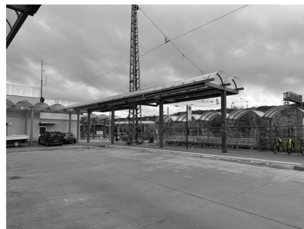
Abb. 31: Radabstellanlagen am Bahnhof
