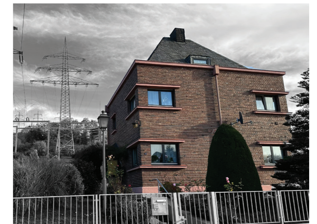
Abb. 50: Zum Wohnhaus umgenutztes Gebäude
